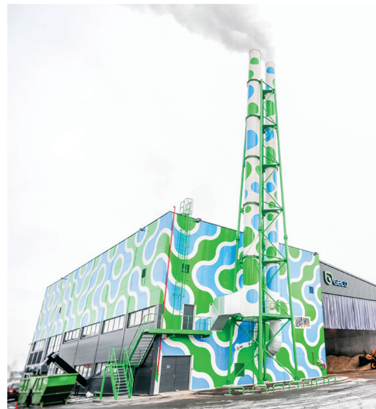
Kompānija Fima kopā ar apakšuzņēmējiem uzstādīja katlumājā galvenās iekšējās un zemsprieguma infrastruktūras, ierīkoja apsardzes sistēmas, automatizēja transporta līdzekļu svēršanas procesu.
