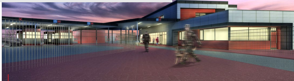
Контрольный пункт Рамбинас будет открыт уже в 2017 г.
