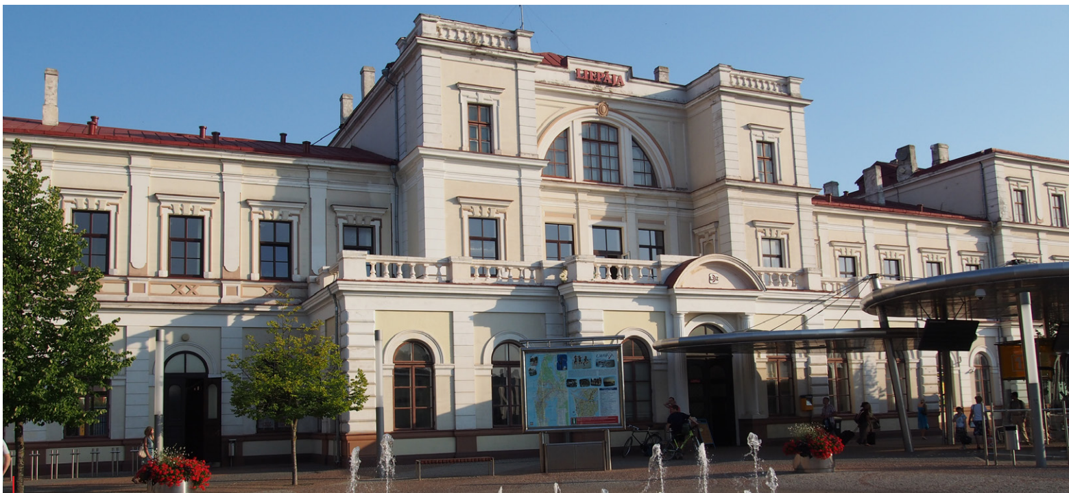
FIMA była zaangażowana w rozbudowę stacji kolejowej w Liepaja
