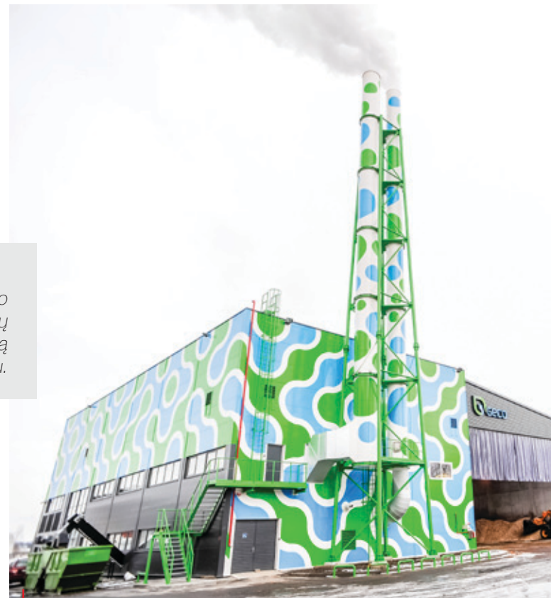
Katilinėje „Fima“ su subrangovais įrengė didžiąją dalį vidutinės ir žemos įtampos elektros tiekimo infrastruktūros, įdiegė apsaugos sistemas, automatizavo transporto priemonių svėrimo procesą.
