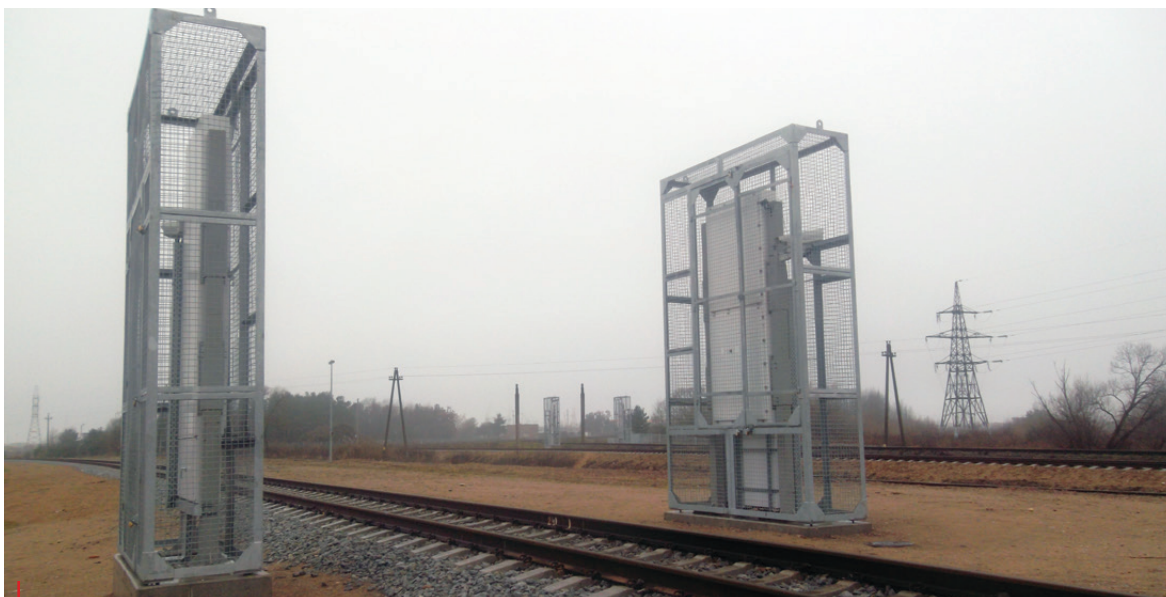
Специальное оборудование фиксирует нарушение, фотографирует нарушителя, определяет место нарушения, опускает шлагбаумы для блокировки проезда транспортных средств, а также передает всю информацию на центральную станцию тревожных сигналов.
