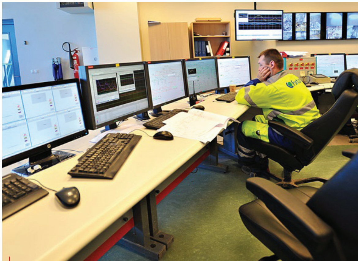
Электронные инженерные решения компании ФИМА позволяют контролировать технологический процесс на электростанции дистанционным способом.
