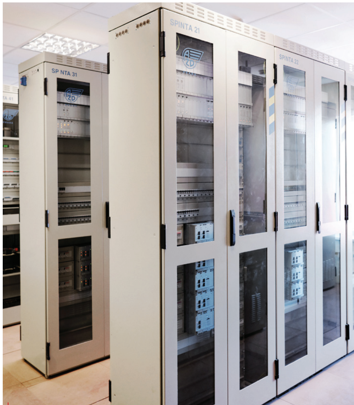
Современная микропроцессорная система управления движением поездов, заменившая находившиеся более 30 лет в эксплуатации электронные и электромеханические системы управления движением.
